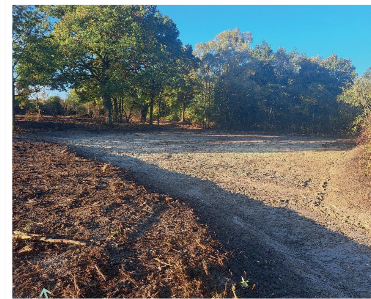
Zone décaissée qui deviendra une zone humide à Chitenay
