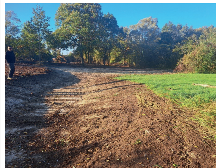
Noue permettant l'alimentation de la zone décaissée qui deviendra une zone humide à Chitenay.
